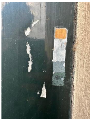
Laag 1: kleurnummer 1647 Laag 2: kleurnummer 1477 Laag 3: kleurnummer 1478 Laag 4: kleurnummer 1572 Laag 5: kleurnummer 1500
